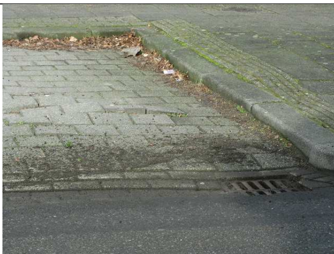
Figuur 3.1 Voorbeeld van een slecht te vegen plaats. Parkeerhaven met scherpe hoeken
