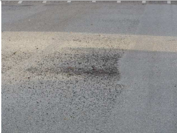
Figuur B3.5.2 Afval dat door de derde bostel te ver op straat is geworpen
